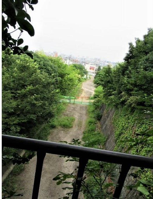
相生山の「道路」シエルトー上より西方向、下山畑交差点、都心方面を望む
