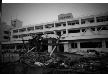
4階に入院した人が溺死した志津川病院
